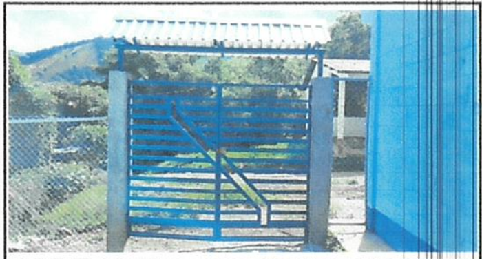
Foto 4: Finalización del portón y techo del mismo
