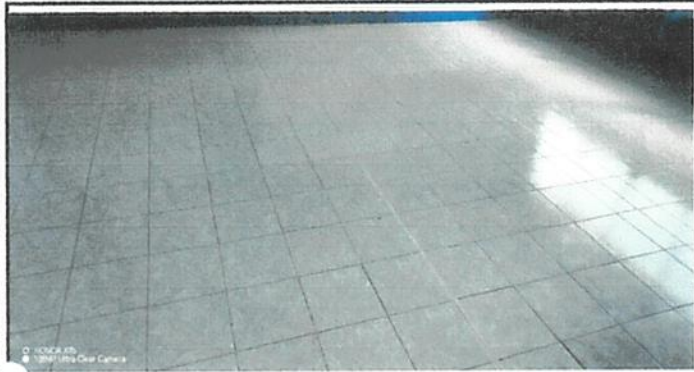
Foto 1: finalización puesta de piso cerámico antideslizante
