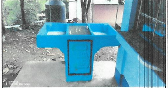
Foto 2: cambio de pileta nueva
