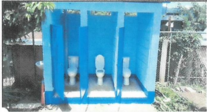
Foto 1: finalización de los sanitarios, instalación de los mismos, lava manos, tuberías y plancha de concreto.
